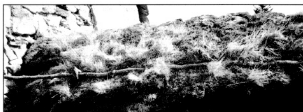
Faitage traditionnel en mottes à Andéol (bâtiment en ruine, l'hiver 1995-96)
