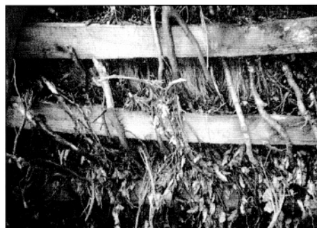
Structure avec genêts piqués sur entrelacs en branches de hêtre (autre partie d'Andéol)
