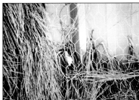
Genêts piqués sur grillage avec sous-étanchéité en bac-acier
