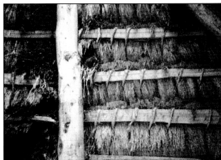
Fond de toit mixte, soit totalement en genêts, soit en genêts piqués sur un vieux toit en paille (technique du Velay) Chaumière d'Andéol
